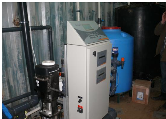
Рис. 5. Растворный узел с ПК и устройствами автоматизированного приготовления рабочего раствора для фертигации земляники с капельным поливом
