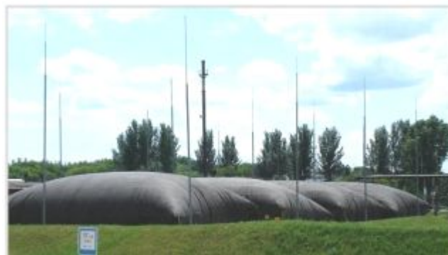
Рис. 1. Навозонакопители бесподстилочного навоза анаэробного (закрытого) типа
