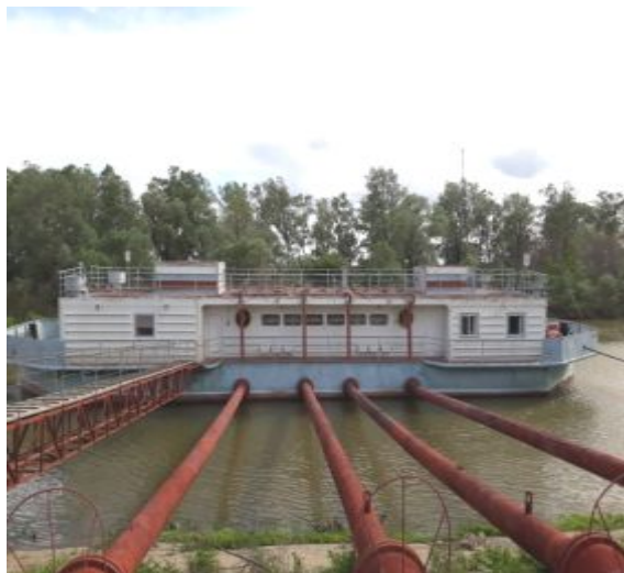
Рис. 1. Плавающая насосная станция, СПК «Ермак» Нововаршавского района (июнь 2018 г.)
